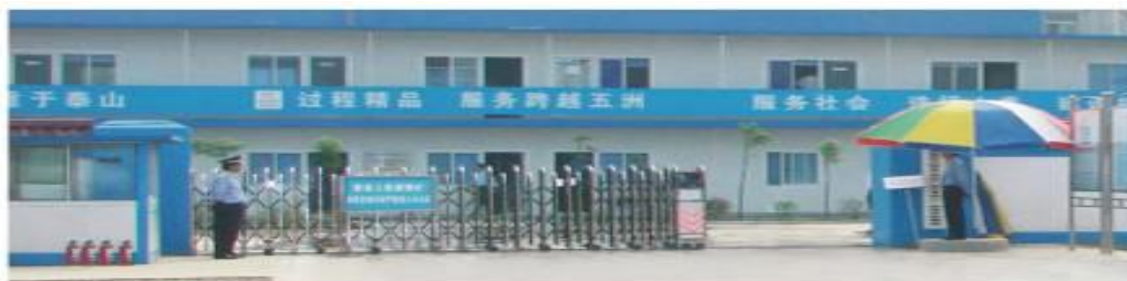
工地办公区大门
