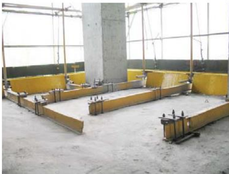
悬挑型钢与建筑物锚固
