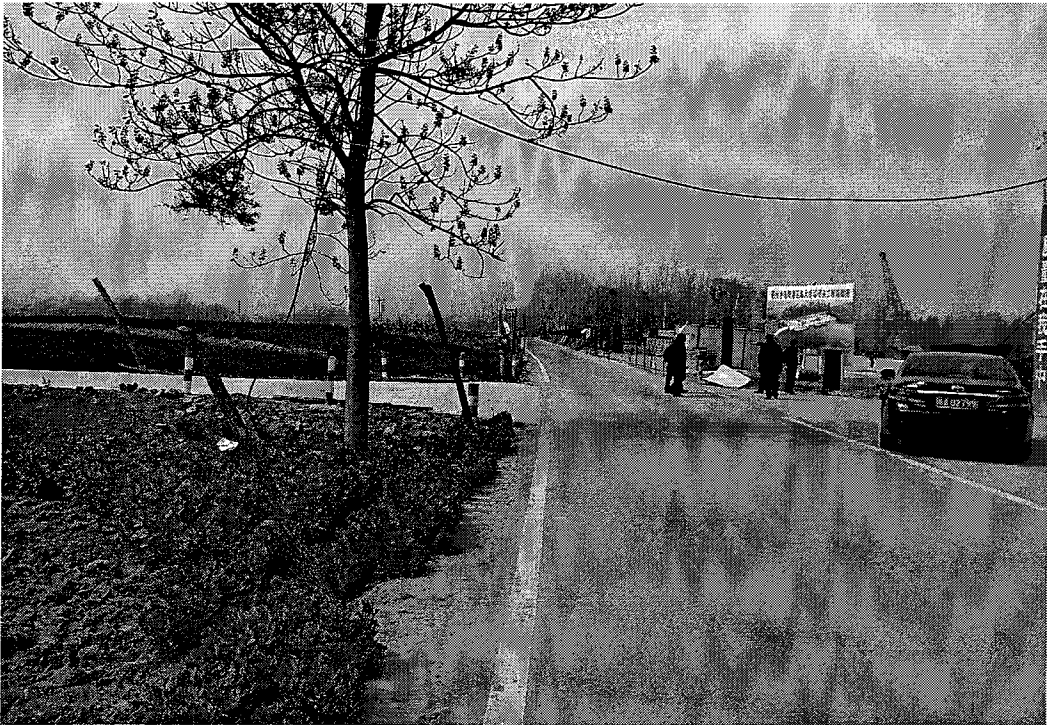
起点现状道路
